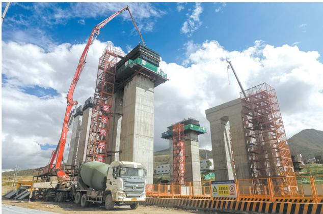
西成铁路化隆车站左右线特大桥正在进行混凝土浇筑作业。
